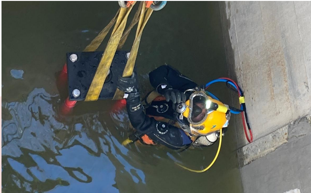
Unterwassermontage des Plattenschiebers DN 1200 – vorerst ohne Antrieb
