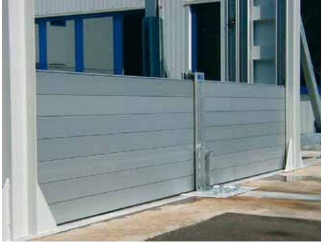
IBS mobiler Hochwasserschutz beim Probeaufbau
