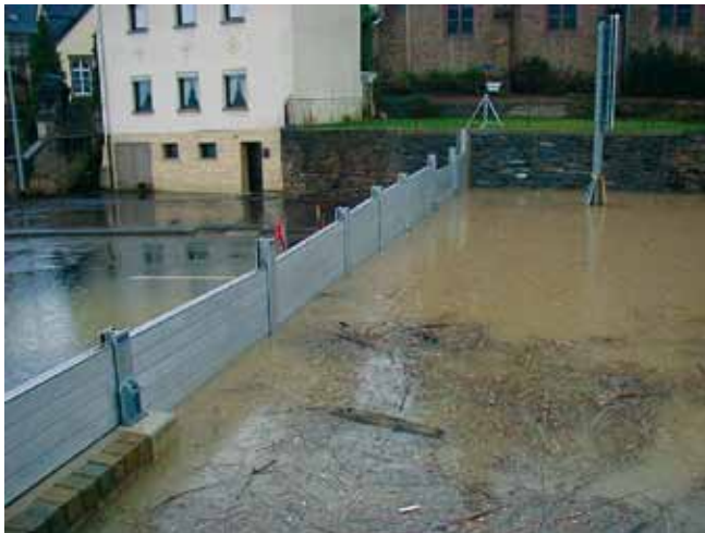
IBS mobiler Hochwasserschutz im Einsatz
