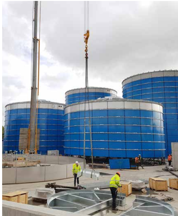
Fermenter Tanks im Bau – September 2018
