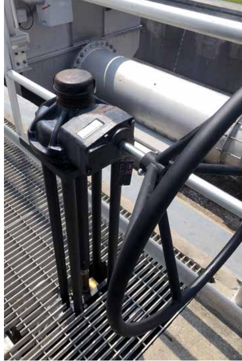
Abgeschlossene Arbeiten an den 20“-Absperrschiebern der W0-Baureihe
