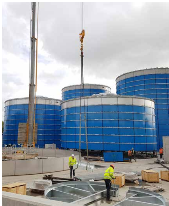
Tanks de digesteur en construction – septembre 2018
