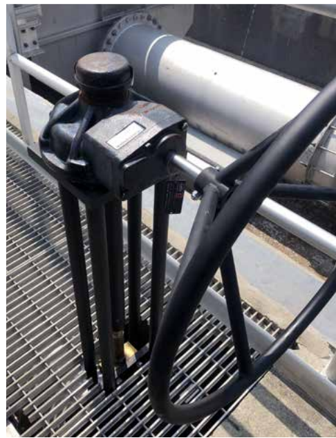
Modifications terminées de la partie supérieure des vannes 20" de la série W0
